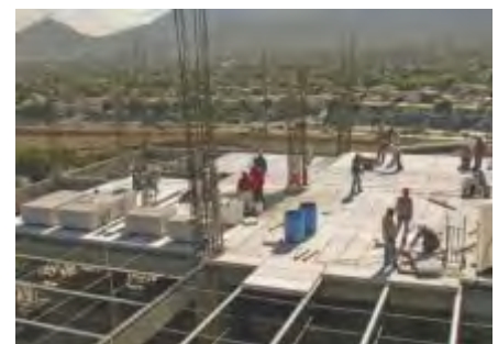
Fig. 10: Revisar la alineación de los paneles y tableros.
