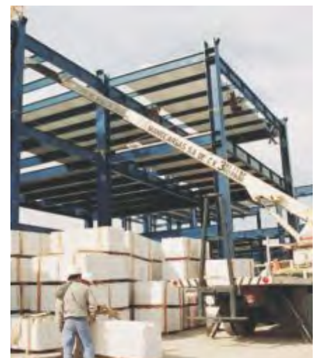
Fig. 2: Almacenamiento de panel Hebel en obra.
