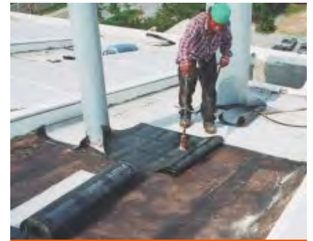
Fig. 22: Impermeabilización de membrana.
